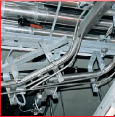
Weichen zu verschiedenen Abnahmepunkten werden nach Bedarf geplant und eingebaut
